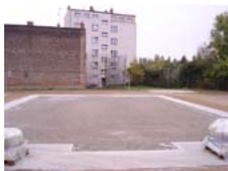
Fertige, ungebundene Tragschicht
